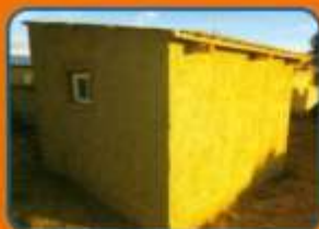
1. Paredes de adobe y techo de: paja, teja o calamina, contra filtraciones
